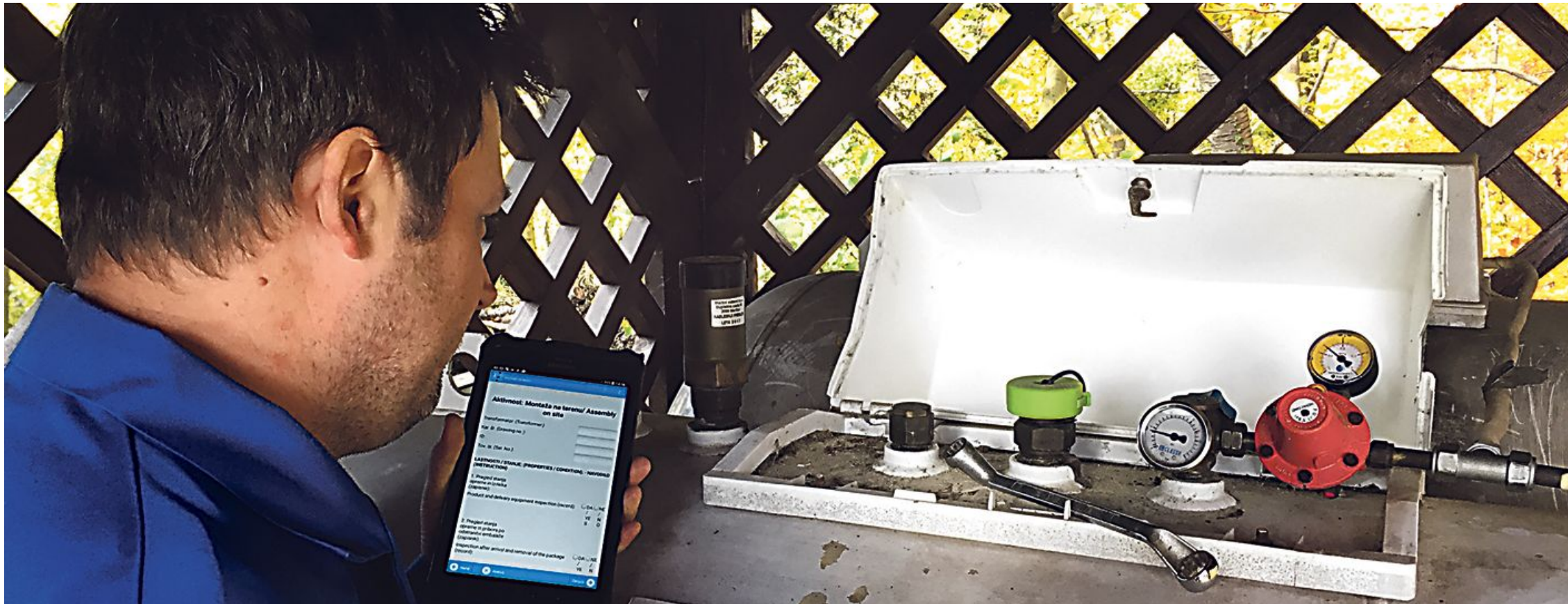
Tehniki in vzdrževalci na terenu pri delu vse pogosteje uporabljajo mobilne rešitve. FOTO I-ROSE
